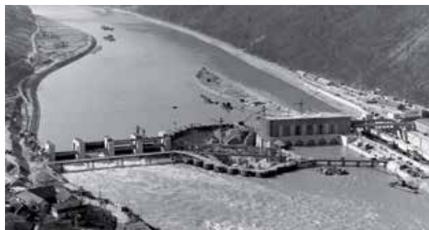
Kraftwerksbaustelle im Juli 1955
